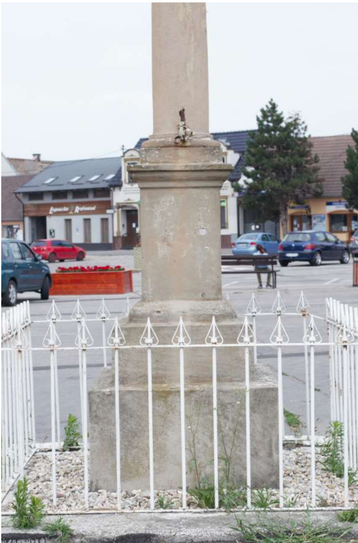
Podstavec stĺpa s kovovým oplotením.
