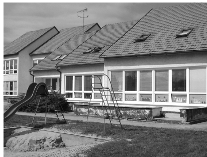
Nové okná v ZŠ Stráže
