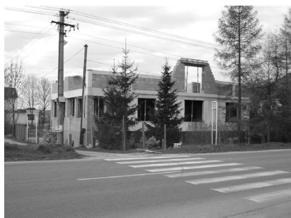
Rekonštrukcia mestskej knižnice
