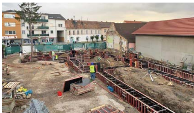
Ukladanie naviazaných výstužných košov do debnenia
