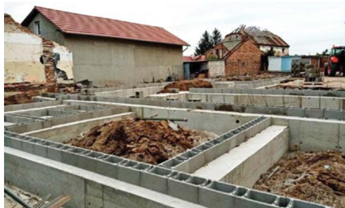
Roznesenie a uloženie DT- tvárnic, armovanie
