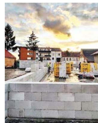
Murovanie obvodových a vnútorných nosných stien
