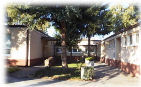
Obr. č. 6: ZPS Šaštín-Stráže Zdroj: www.zps-ss.sk
